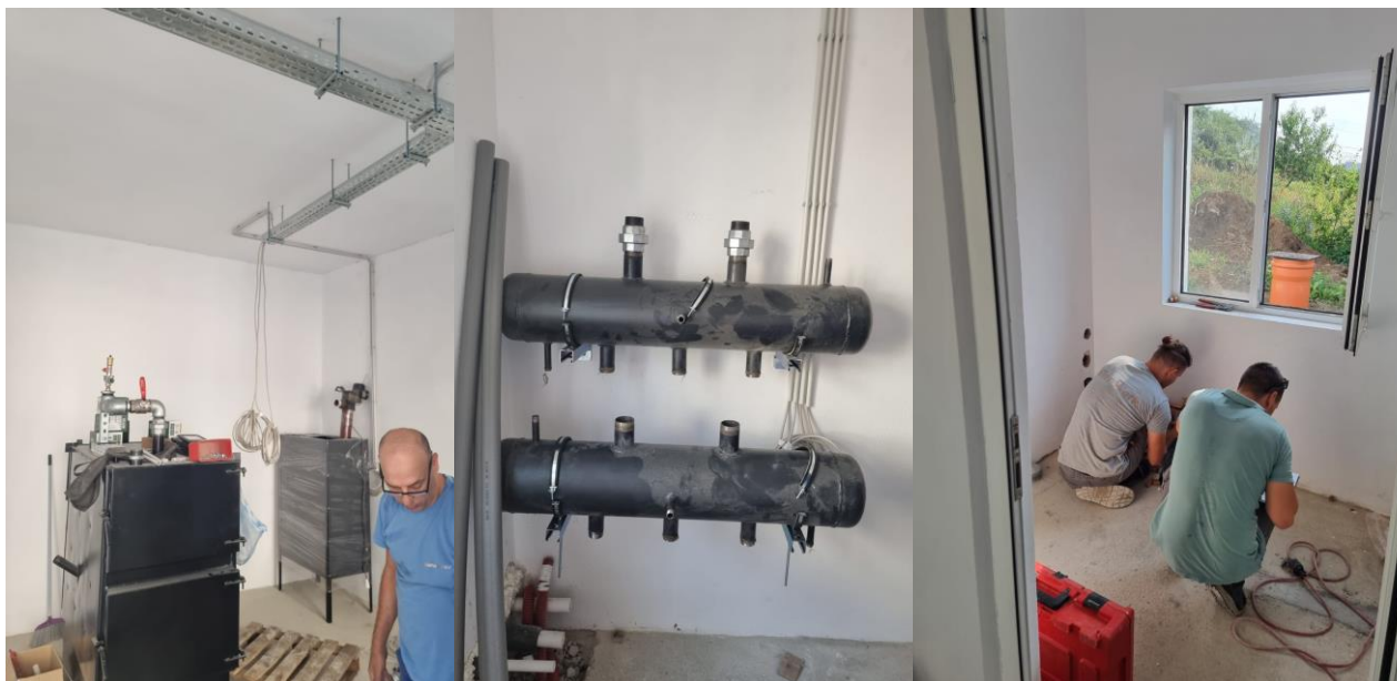
Fig. 3.2 Montarea instalației de ardea a biomasei
